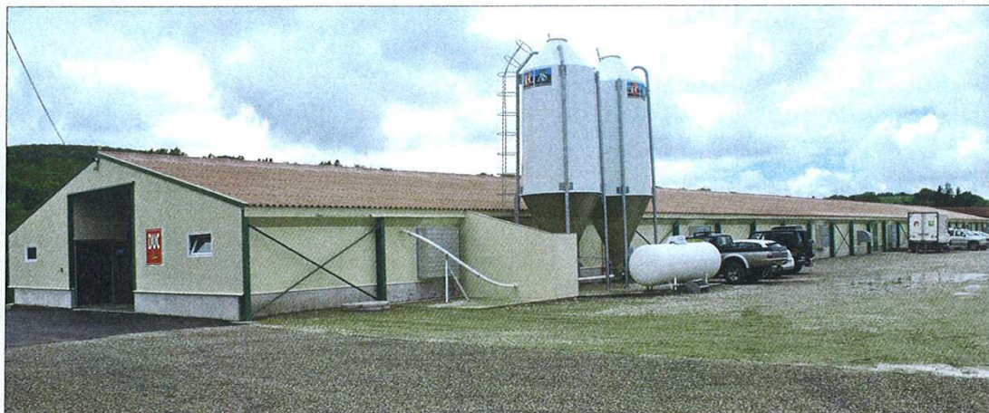
▲ Bâtiment de 1 500 m 2 à ventilation transversale pour Emmanuel Dochier.
