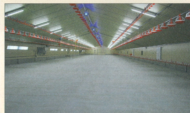
▲ Le poulailler est équipé de trois PRC 180, deux PGE 85, six turbines de 40 000 m 3 /h, sept ventilateurs, trois chaînes d'alimentation, quatre lignes de pipettes et d'une ventilation avec entrée d'air à gauche et rejet d'air vicié du côté droit.
